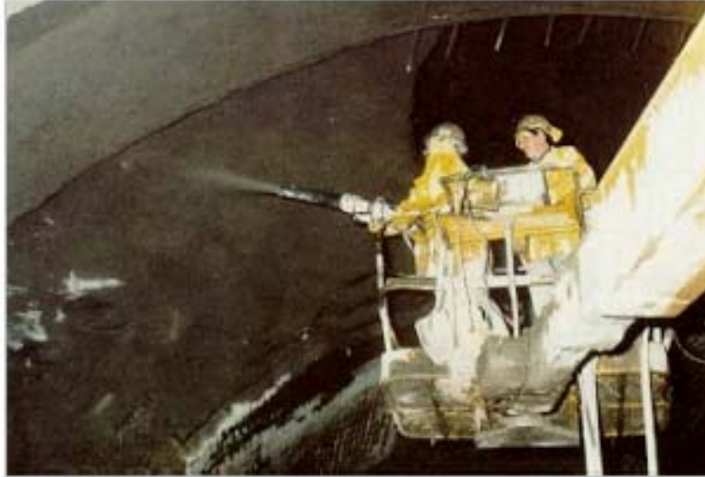
Σχ.3.17'. Εκτοξευόμενο σκυρόδεμα για προσωρινή υποστήριξη
