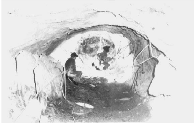
Σχ. 1.13. (α,β) Αστοχία στοάς με την μορφή απολέπισης και χαρακτηριστικών θραύσεων αντιδιαμετρικά στις παρυφές της.
