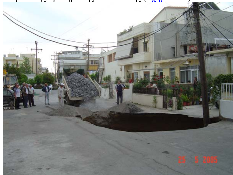
Σχήμα 1.16 Εμφάνιση επιφανειακού κρατήρα λόγω κατάρρευσης του μετώπου μίας σήραγγας κατά την φάση εκσκαφής.
