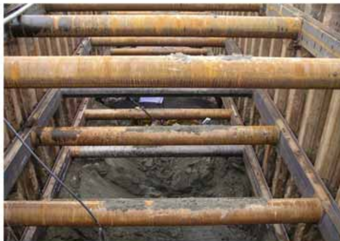
Σχήμα 10.29. Διάταξη στοιχείων αντιστήριξης κατά το τέταρτο και τελικό στάδιο εκκαφής (βάθος -9.0 m)
