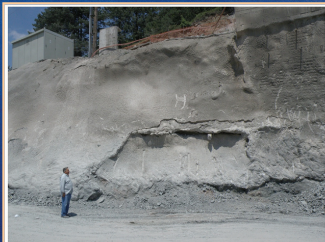
Σχήμα 9.9. Θέση κατασκευής του τοίχου ΤΣ1 στην είσοδο της σήραγγας Συρτού σε κοντινό πλάνο
